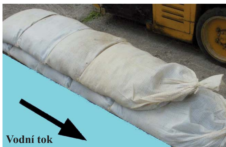
Obr. 4.34 Jednořadá kladení jednokomorových pytlů [11]
