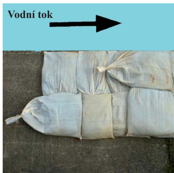
Obr. 4.35 Víceřadá kladení pytlů [11]
