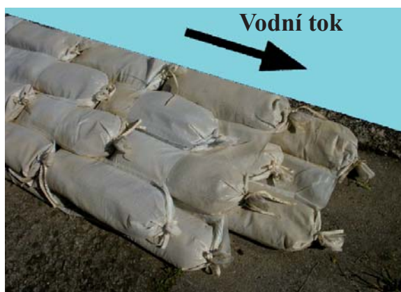
Obr. 4.36 Kladení dvoukomorových pytlů [11]
