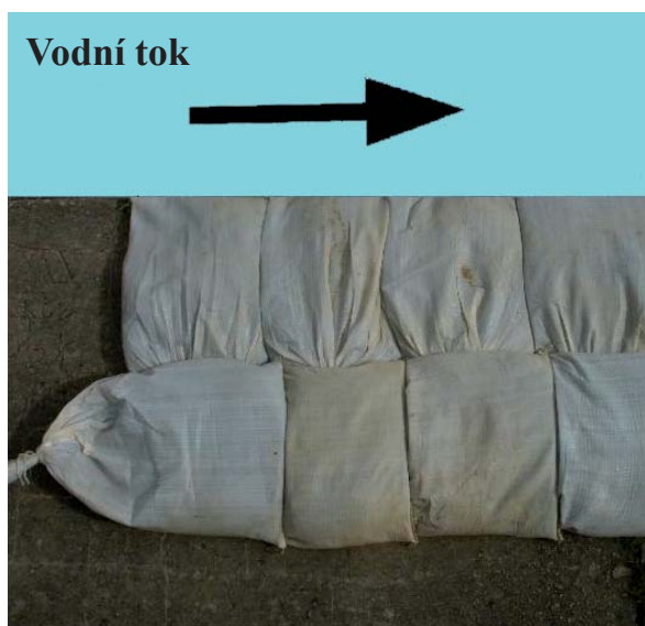
Obr. 4.35 Víceřadá kladení pytlů [11]
