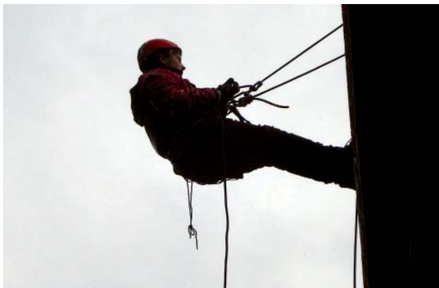
Obr. 5.37 Jištění druhým lanem
